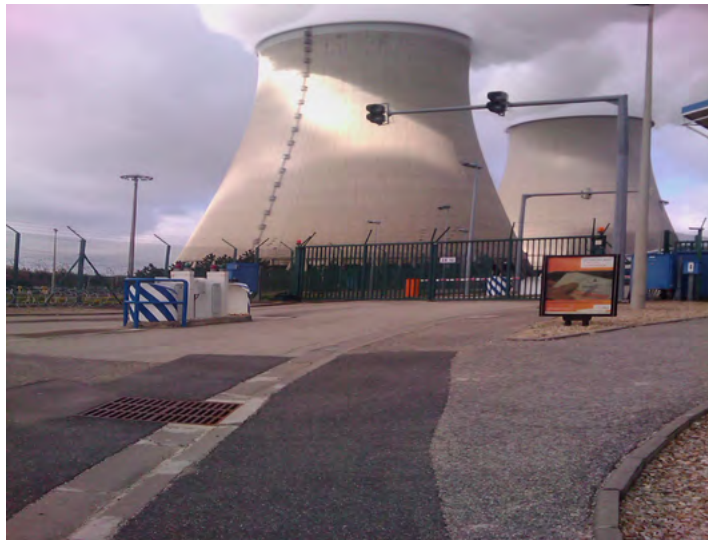
Centrale nucléaire de Nogent
